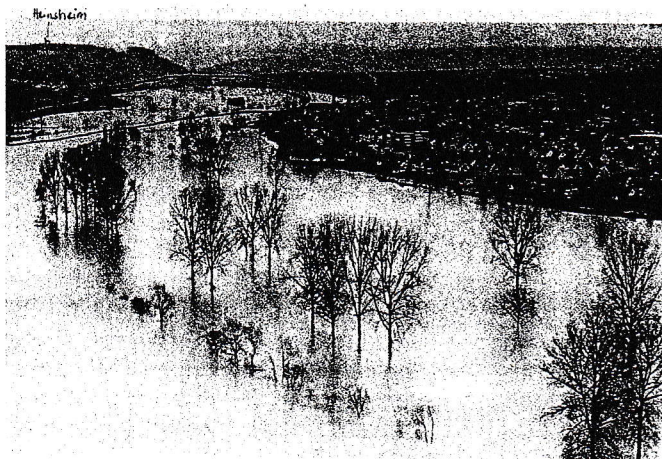
Abb. 1: Die Flutmulde zwischen Heinsheim und Offenau. Hier ist das Hochwasser vom 17. 3. 1988 zu sehen.
